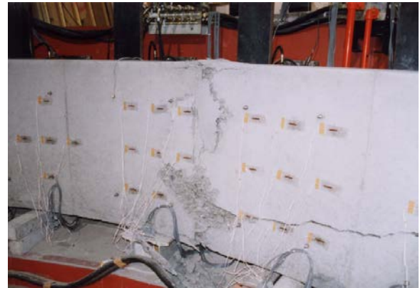
図-1 コンクリート表面が圧ざしている状況の一例
