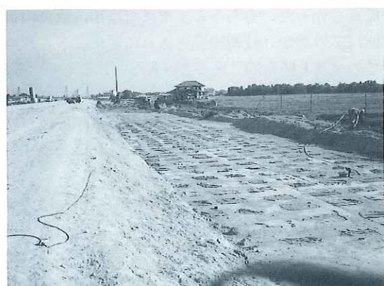
写真-1 低改良率セメントコラムの施工状況
