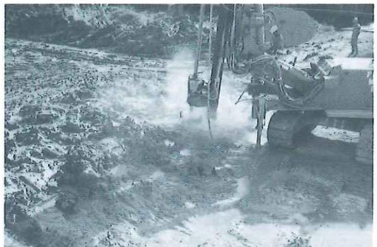
写真-2 ジェットグラウト方式による深層混合処理機械の例
