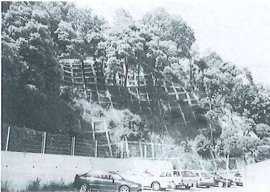
写真-1 樹木を残したのり枠工の事例
