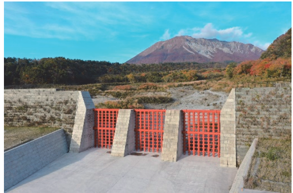
写真-4 鋼製透過構造を有する二の沢砂防堰堤
