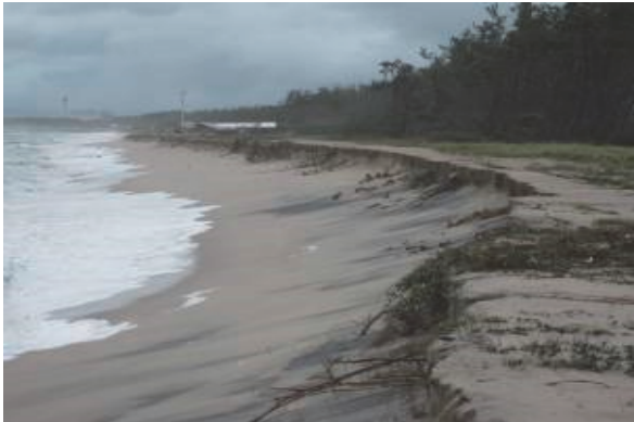
写真-1 侵食の激しい富益工区（平成23年9月撮影）
