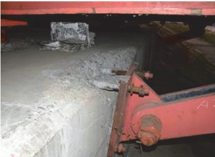
写真-1 縁端付近に取り付けられた落橋防止構造の取付部の損傷（アンカーの引き抜け）<sup>3)</sup>
