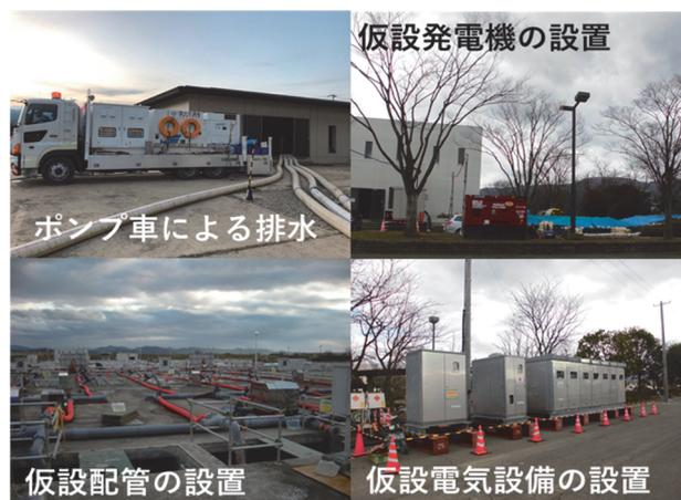
図-3 緊急・応急復旧措置事例
