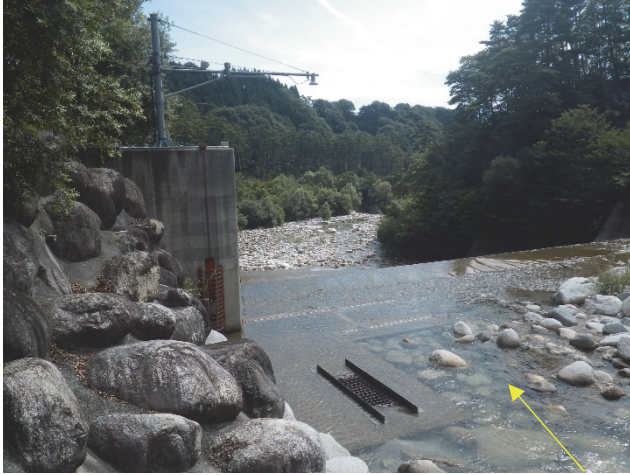
図-1 坊主平砂防堰堤
