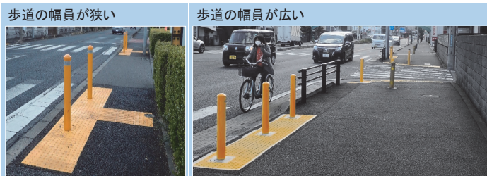
写真-3 H型ボラードよりも前に誘導用ブロックを配置
