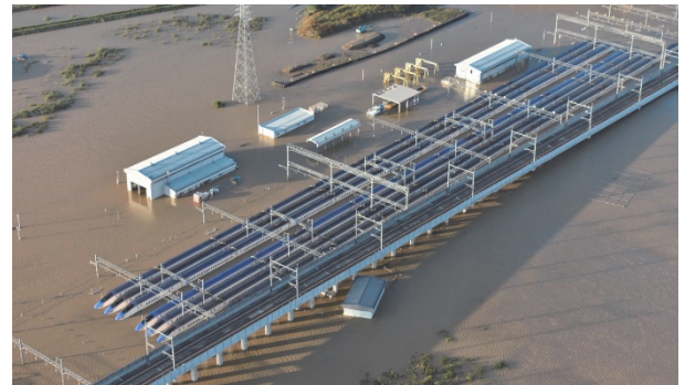
写真-1 長野新幹線車両センターの浸水状況
