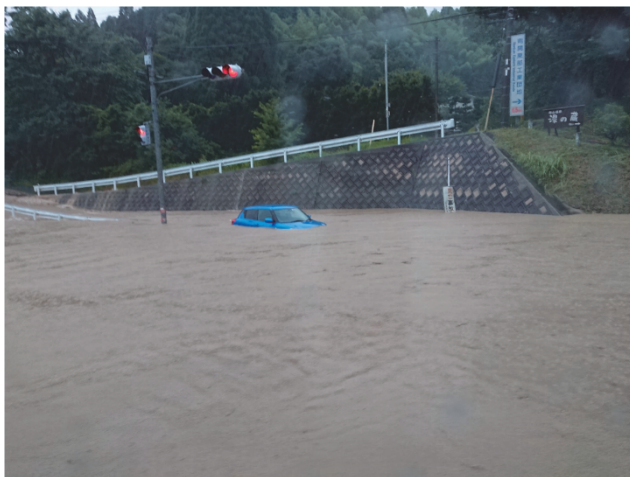
写真-2 周辺浸水状況 (R2.7.6南関町)
