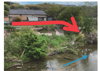
写真-4 氾濫流戻り箇所
