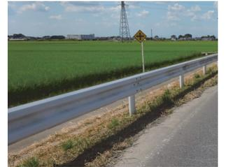
写真-1 車両用防護柵の一例(ガードレール)
