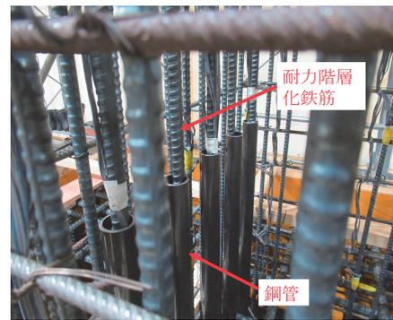
写真-1 耐力階層化鉄筋の上端部
