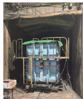
写真-2 蒸気養生設備の正面写真
