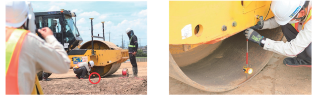
写真-1 静止状態での精度確認実施状況
