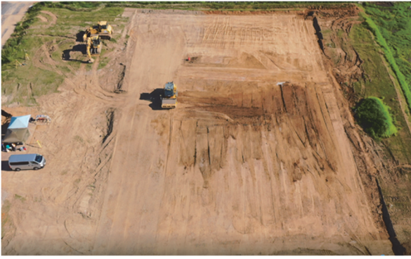
写真-3 転圧状況
