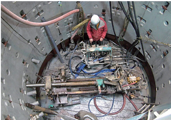
写真-4 集水井工の施工状況
