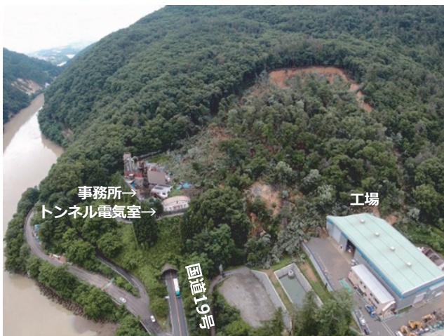
写真-1 地すべり全景（令和3年7月6日撮影）
