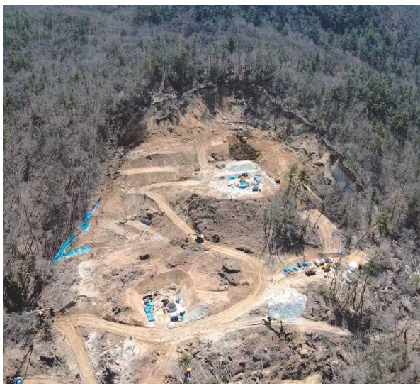
写真-5 頭部排土工の施工状況
