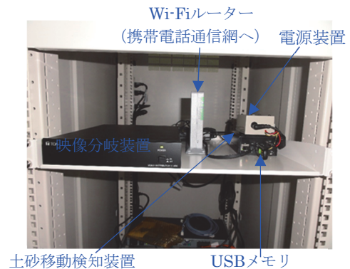
写真-1 土砂移動検知装置とその周辺機器の設置状況
