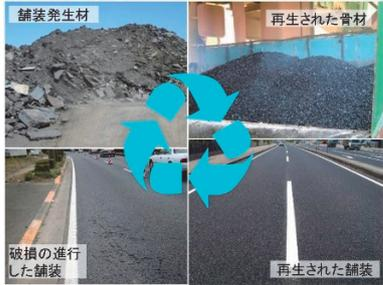
図-1 アスコン塊の再生利用の重交通路線への拡大
