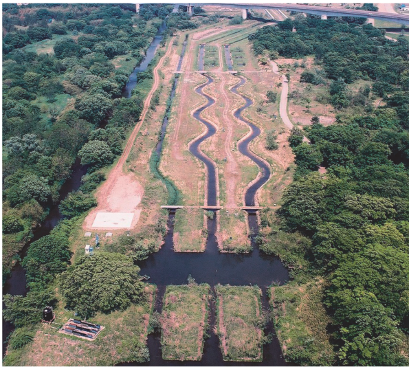
写真-3 水生生物の挙動把握に用いる実験河川
