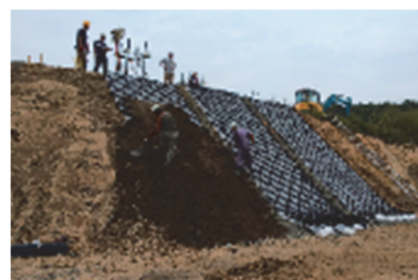
写真-4 のり面保護の試験施工
