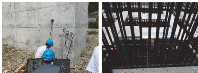
写真-3 透気・透水による品質評価(左)と打ち込み・締固め時の足場の工夫による表層品質向上の取り組み事例(右)
