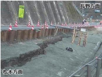
鋼矢板打設完了状況 (R3. 3. 26)
