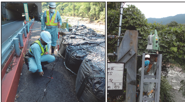
写真・3 動態観測状況(左:手計り観測、右:TS設置状況)
