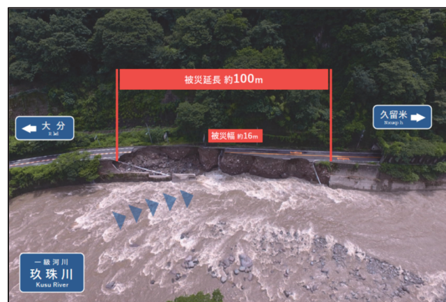
写真-1 被災状況写真（令和2年7月9日撮影）
