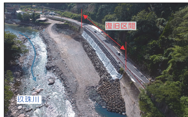
写真-2 応急復旧完了後の全景（令和2年8月17日撮影）
