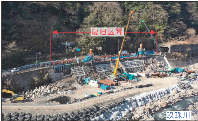
写真-4 本復旧対策工事の現況(令和4年3月時点)
