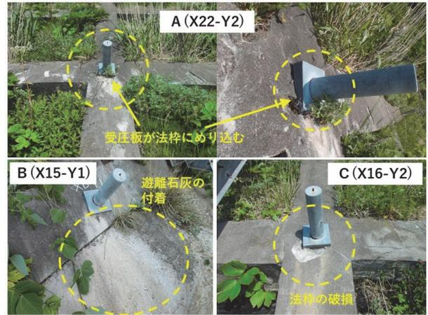
写真-1 アンカー頭部の変状状況
