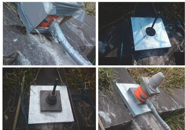
写真-2 アンカーAの法枠補修状況
