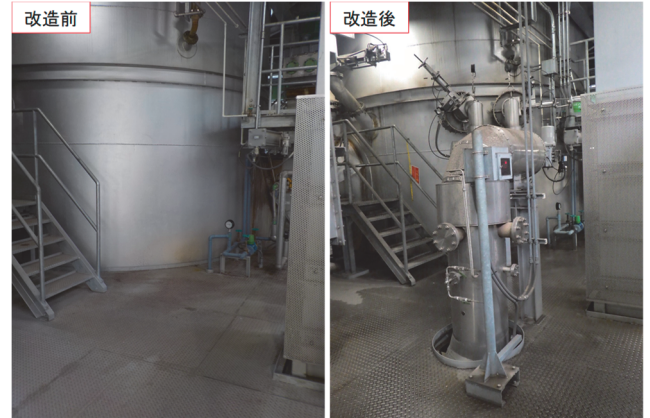
写真-1 焼却炉改造前後比較 （左：2系焼却炉 右：3系焼却炉）
