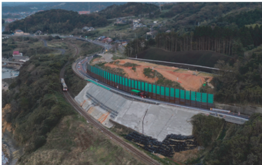
写真-9 片側交互通行による供用開始
