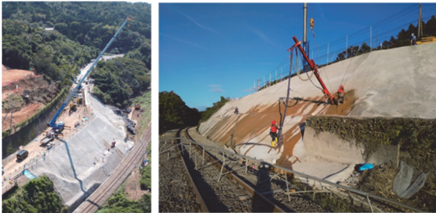
写真-8 JR側法面鉄筋挿入状況
