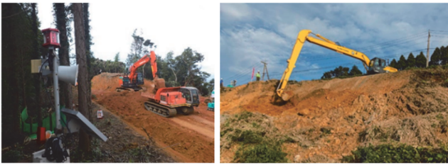
写真-6 頭部排土状況 写真-7 JR法面整形状況
