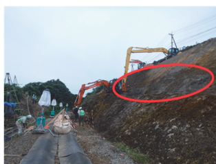
写真-4 JR側法面泥岩層
