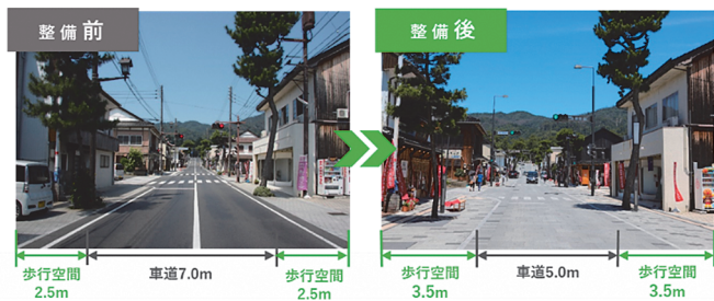
写真・3 整備前後の幅員構成
