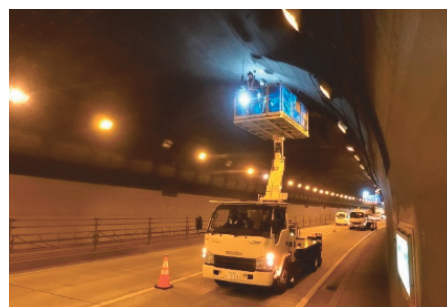
写真-1 道路トンネルの定期点検の実施状況
