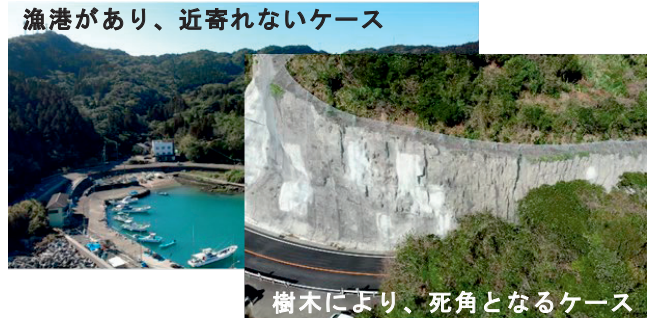
図-8 UAVでの道路状況確認が困難な箇所の例
