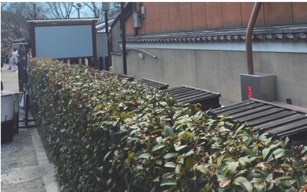
写真-3 焼き杉板で美装化した地上機器を集中配置し、生垣で目隠した事例
