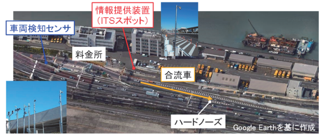
図-6 東京臨海部実証実験 （首都高速1号羽田線空港西入口（上り））
