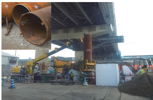
写真-3 鋼管杭施工状況（左上：先端ビット）
