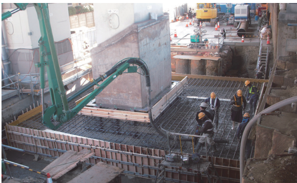
写真-2 増厚補強と鋼管矢板基礎の増杭補強状況
