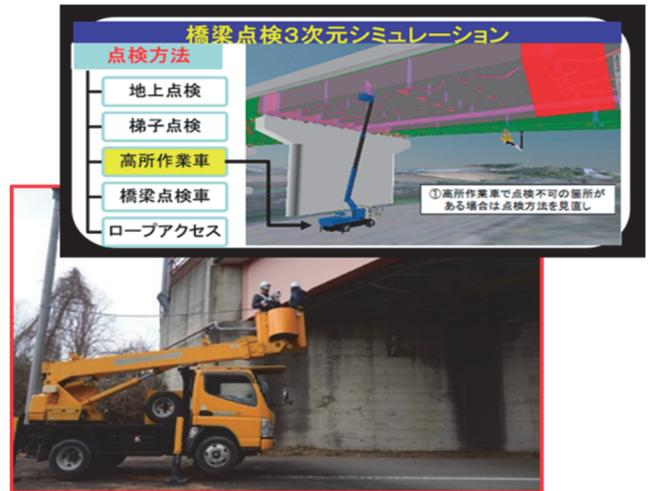
図-1 点検作業者がタブレット端末によりシミュレーションを活用しているイメージ
