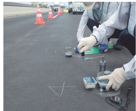
写真-2 引張接着強度試験の状況（大平高架橋）
