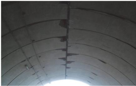
写真-2 接合部の損傷
