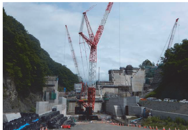
写真-4 ブロックレヤー工法による本体打設
