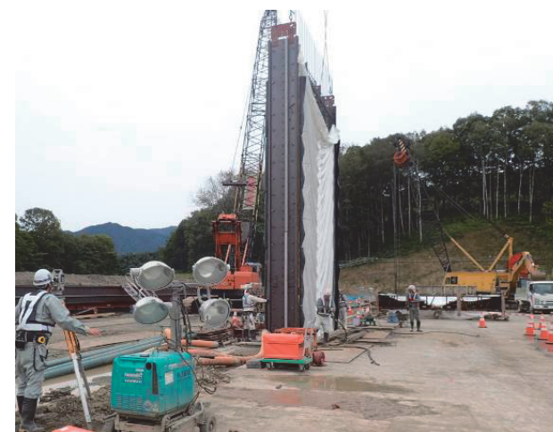
写真-6 地中連続壁の施工状況
