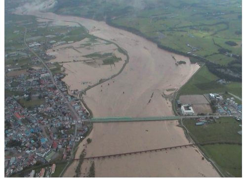
写真-3 沙流川下流浸水状況(下流から望む)
