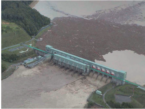
写真-2 二風谷ダム洪水調節状況(下流から)
