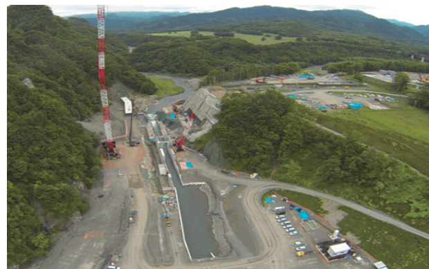
写真-5 半川締切方式による転流工
