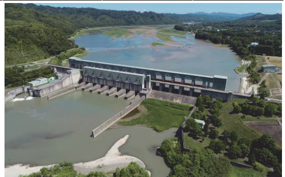
写真-1 二風谷ダム
