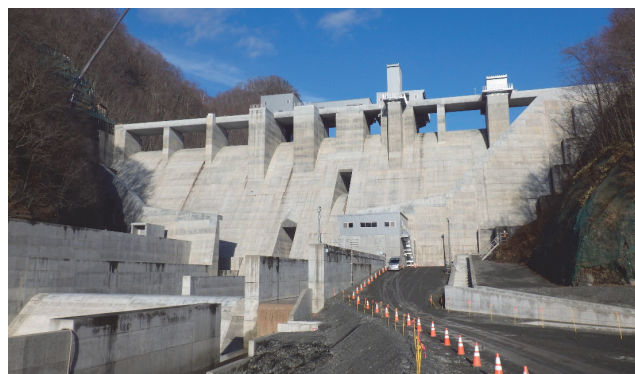
写真-7 平取ダムの状況（令和3年12月7日）
