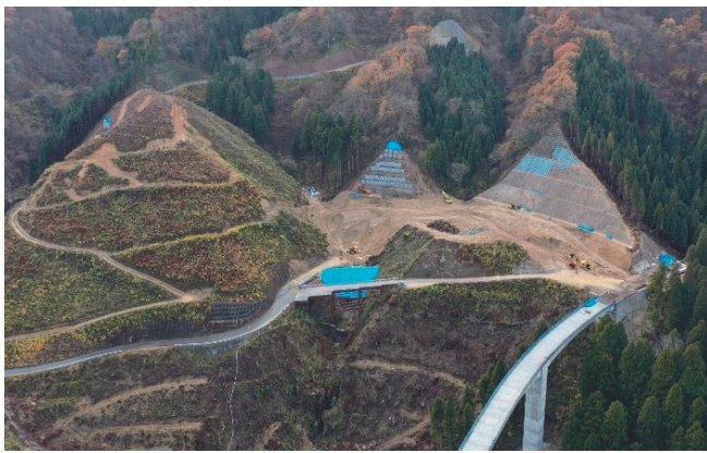
写真-2 原石山掘削状況（2021年11月）
