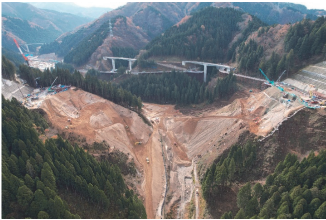
写真-1 ダム本体基礎掘削状況（2021年11月）
