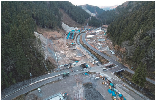
写真-3 骨材製造設備施工状況（2021年11月）
