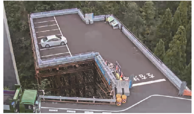
写真-8 ダム本体建設工事展望台（2021年11月）
