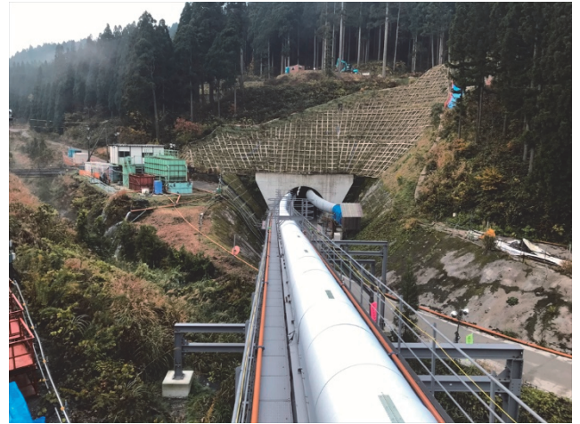
写真-4 水海川導水トンネル吐口（2021年11月）
