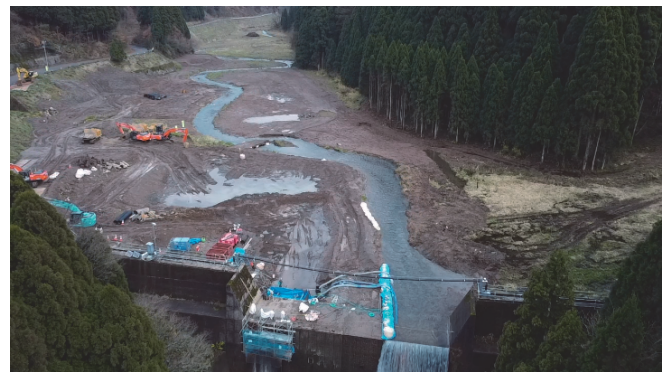
写真-5 水海川分水堰河床掘削状況（2021年11月）
