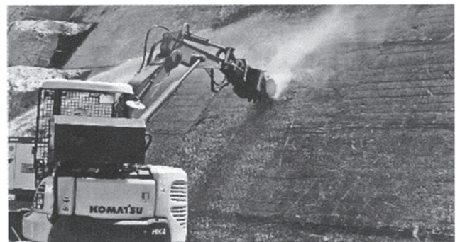
図-4 新桂沢ダムの既設堤体下流面のチッピング 12)
