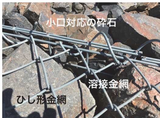
写真-2 かご工上端部の連結状況
