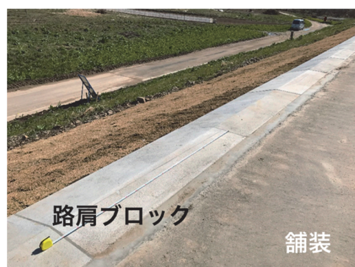
写真-6 裏のり肩のブロック設置
