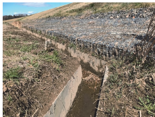
写真-1 かご工の全景
