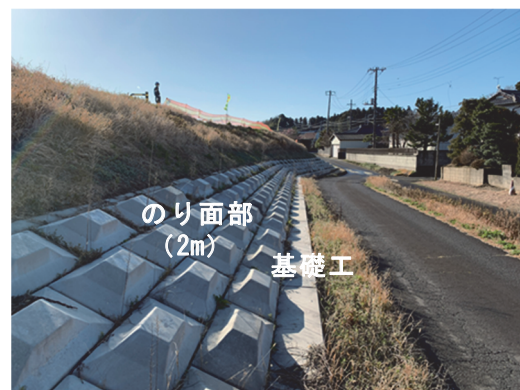
写真-4 連節ブロックにより補強（平場なし、Bタイプ）
