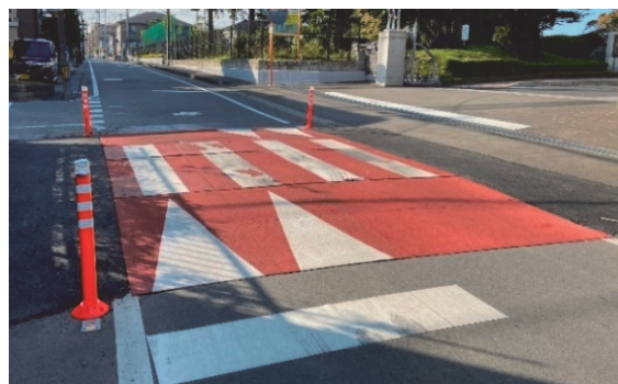
図-11 国総研の可搬型ハンプ設置例
