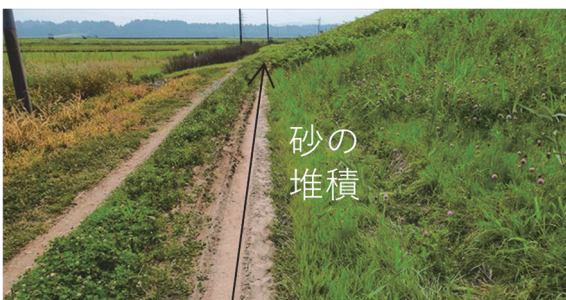
写真-2 最上川右岸81.5k付近の法尻で確認された噴砂による砂の堆積
