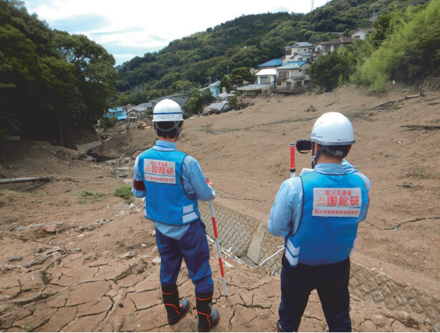
図-5 土砂災害現場に派遣された国総研職員と地方整備局職員（令和3年8月静岡県熱海市）
