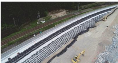
写真-2 大型土のう積層状況
