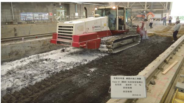
写真-1 路床の生石灰混合状況
