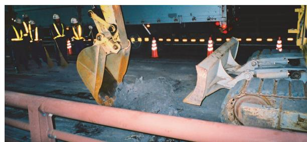
(b) 切削後に残ったAs舗装の除去
