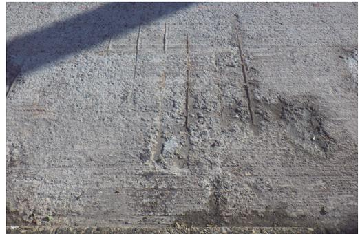
写真-3 かぶり不足や切削による床版上面の鉄筋露出
