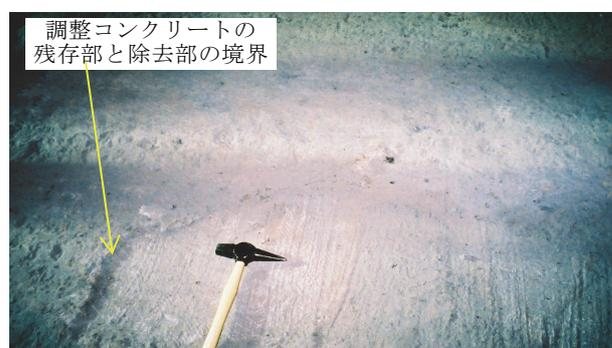
写真-2 調整コンクリートの部分的な除去
