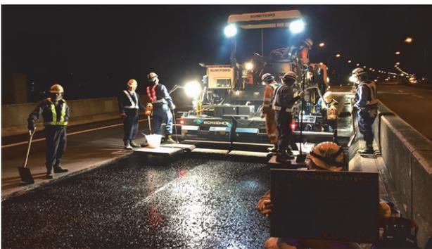
写真-5 コンクリート床版用グースアスファルト舗装の施工
