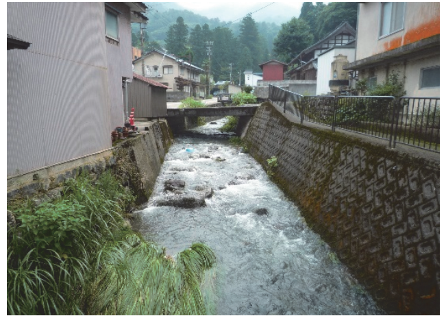
図-4 工事着手前
