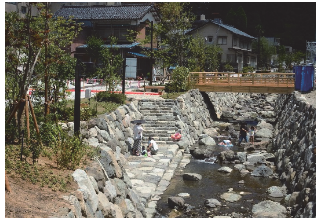
図-5 工事完成後
