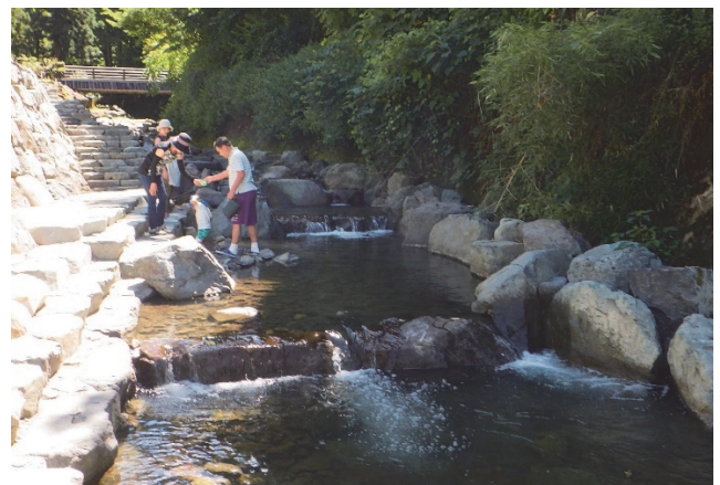
図-6 自然石で施工した落差工
