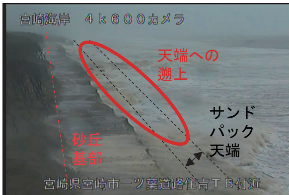
図-5 宮崎海岸のCCTV画像 (令和2年9月6日18時)
