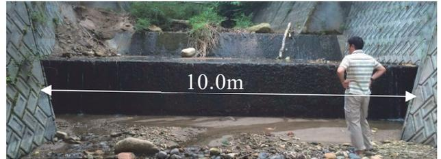
図-1 竜の口溪谷の堰堤（堰堤両岸に擁壁護岸）
