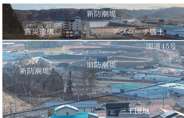
写真-32 山地造成による高台移転：宮古市田老三王
