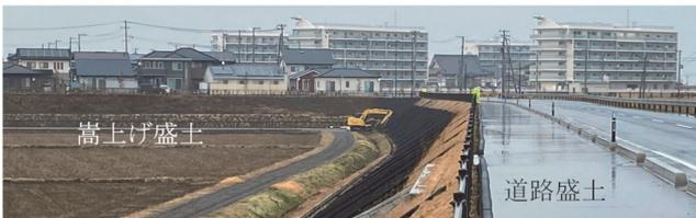
写真-39 嵩上げ地盤による移転住宅地：名取市閑上
