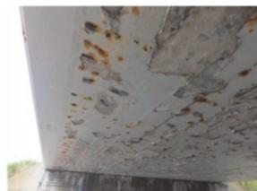
写真-2 表面被覆後の再損傷事例
