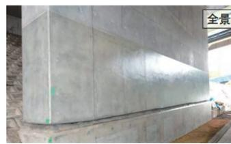
写真-3 コンクリート表面の可視性を有する表面被覆の例
