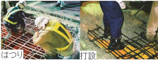
写真-3 床版コンクリート全厚の部分打換え
