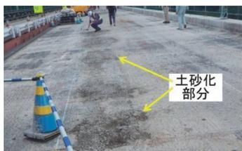
写真-1 舗装下のRC床版の土砂化
