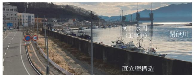
写真-1 津波の越流に耐えた直立壁構造：宮古市新川町
