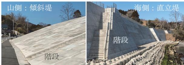
写真-8 裏法傾斜構造の防潮堤：気仙沼市石浜漁港
