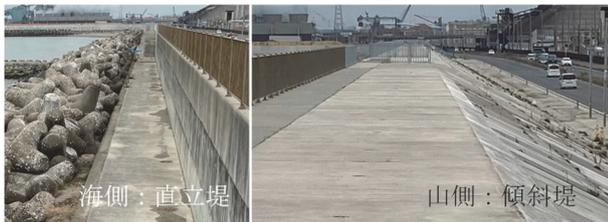
写真-9 裏法傾斜構造の防潮堤：石巻市雲雀野町
