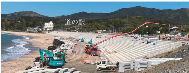
写真-18 傾斜堤(奥)とCSG堤(手前)：気仙沼市大谷海岸
